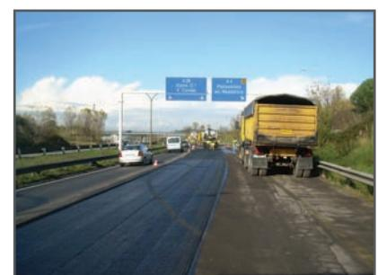
Применяется для битумных покрытий, (гибких) поверх старых жестких поверхностей (бетонных плит) или полужестких. А также очень эффективен при расширении дорог.
